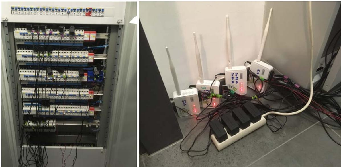
Abbildung 1.2: Datenübertragungsbox und Klappwandler in einem gut zugänglichen Unterverteiler in einem absperrbaren Raum
