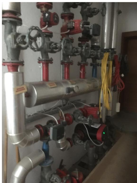
Abbildung 5.4: Beispiel für Gasheizung mit gemischter Pumpenstruktur
