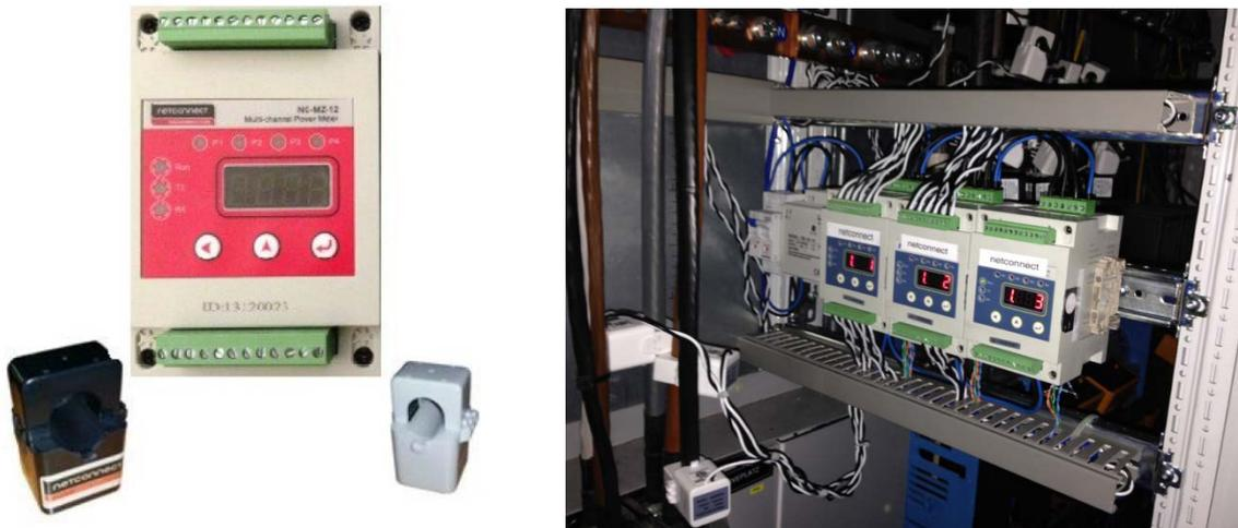
Abbildung 1.13: Wandlermessung mit Bildstromerfassung (Quelle: Fa. netconnect)
